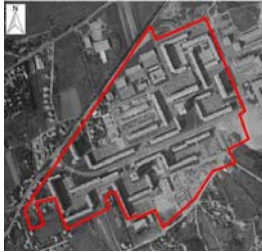
1966 : Premiers habitants accueillis dès 1965. Travaux en cours sur la partie Sud
