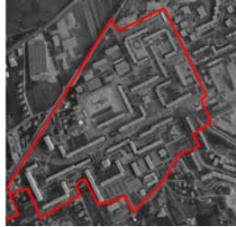
1971 : Travaux de la ZUP terminés
