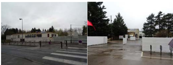
Figure 62 : Groupes scolaires des Alagniers(à gauche) et Mont Blanc (à droite) (Source EVEN Conseil)
